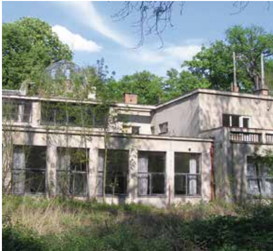
Současný stav budovy bývalých lázní v Houštce.
